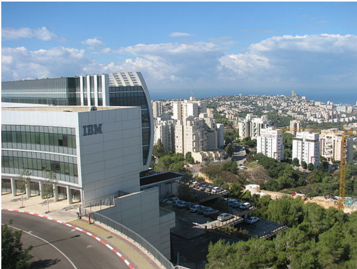
Un bâtiment IBM de R&D à Haïfa en Israël
